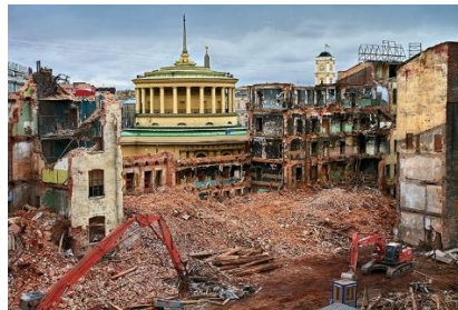
Рис. 2. Снос зданий по адресу Невский пр. 114 и 116/2 - исторически сложившегося ансамбля Невского проспекта. Ради возведения очередного универмага принесен в жертву дом благотворительного общества Знаменской церкви (построен в 1887 году по проекту А. Иванова)
